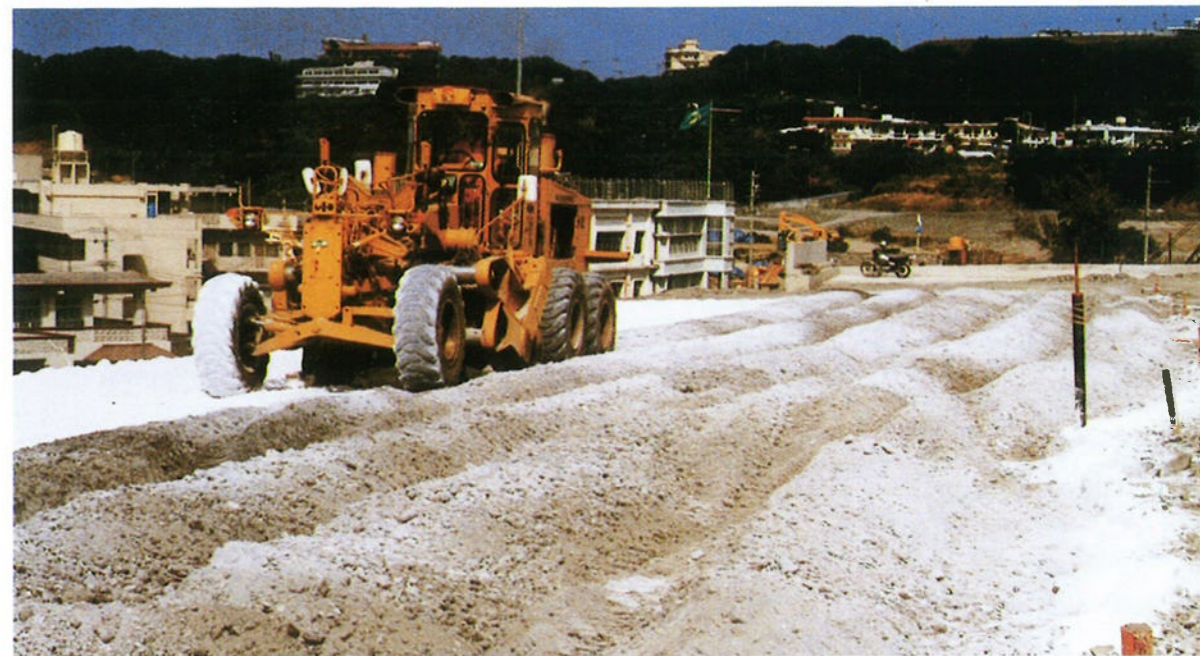
沖縄自動車道北中城の工事（上部路床安定処理）
