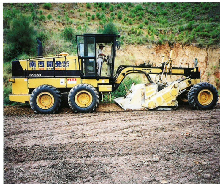
路床安定処理（攪拌状況）
