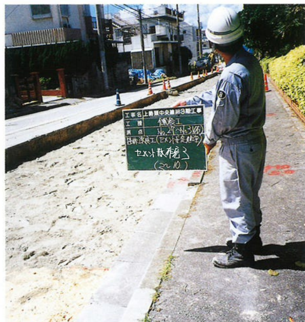
路床安定処理（セメント散布）
