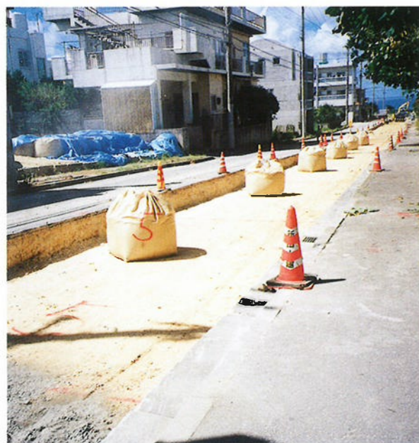
路床安定処理（セメント配置状況）
