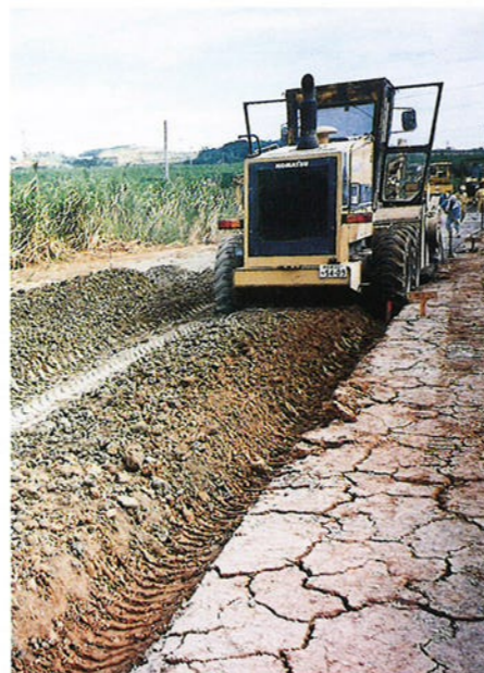
路床安定処理（攪拌状況）
