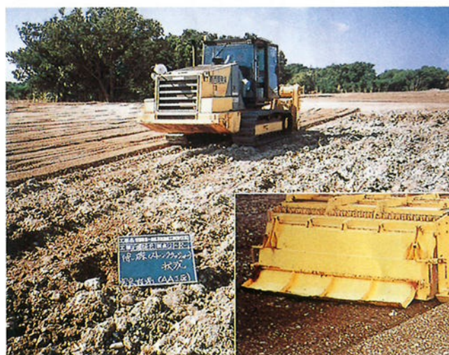
ストーンクラッシャによる石礫連続破碎状況（左上）と細粒化の状況（右下）
