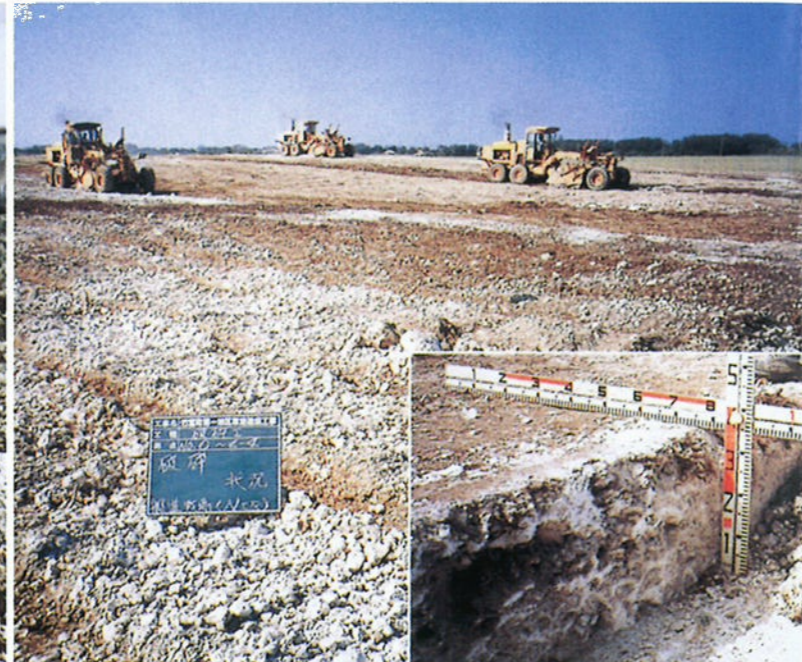
スタビライザによる岩盤破碎状況（左上）とその破碎断面（右下）
