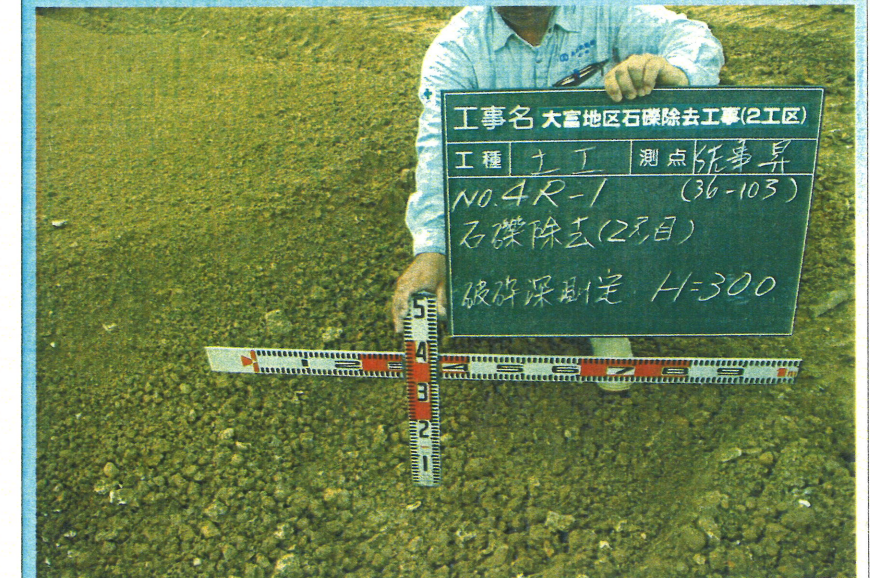
破碎深測定(2層目)
