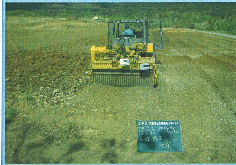
石礫破碎(2層目)(ストーンクラッシャー使用)
