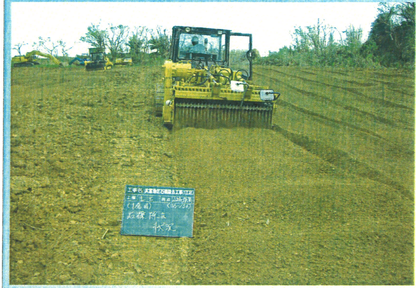
石礫破碎(1層目)(ストーンクラッシャー使用)
