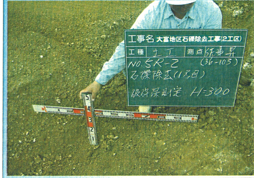
破碎深測定(1層目)
