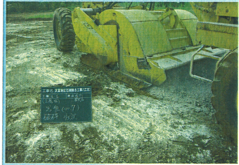
岩盤部破碎(2層目)(スタビ使用)
