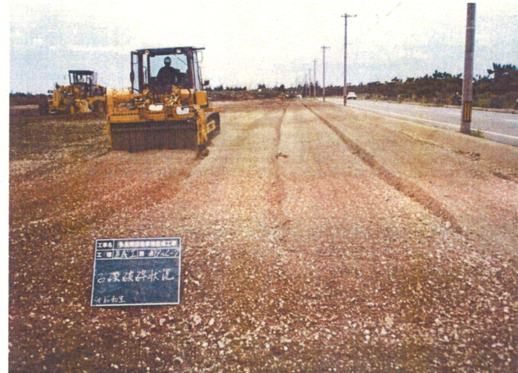
(ストーンクラッシャー石礫破碎)
