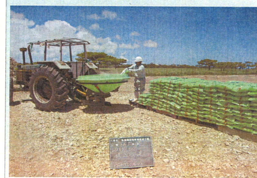
土壤改良材積込 (BMヨーリン)
