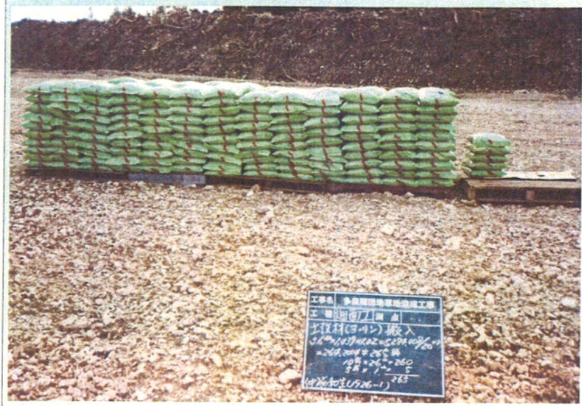
土壤改良材搬入 (BMヨーリン)
