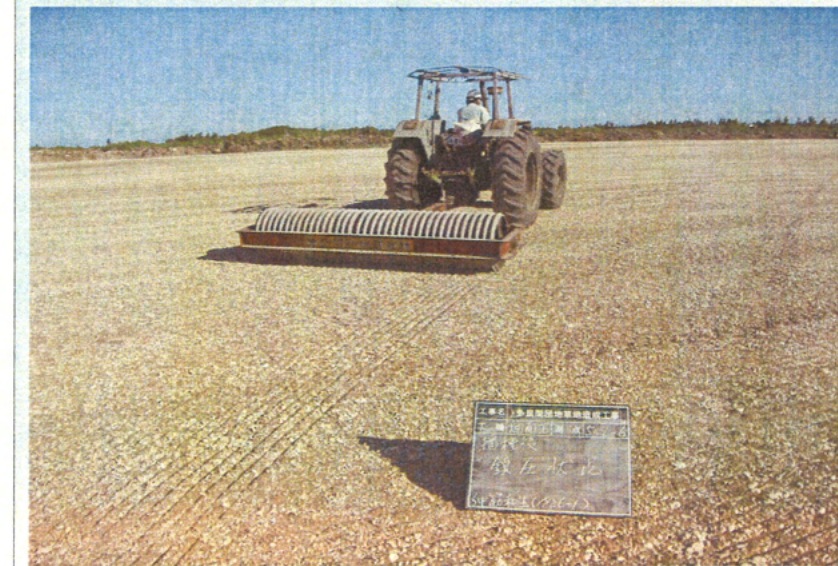
鎮圧(ケンブリッジローラー)
