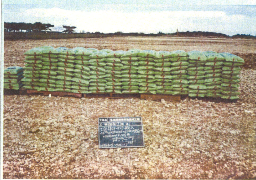
土壤改良材搬入 (BMヨーリン)
