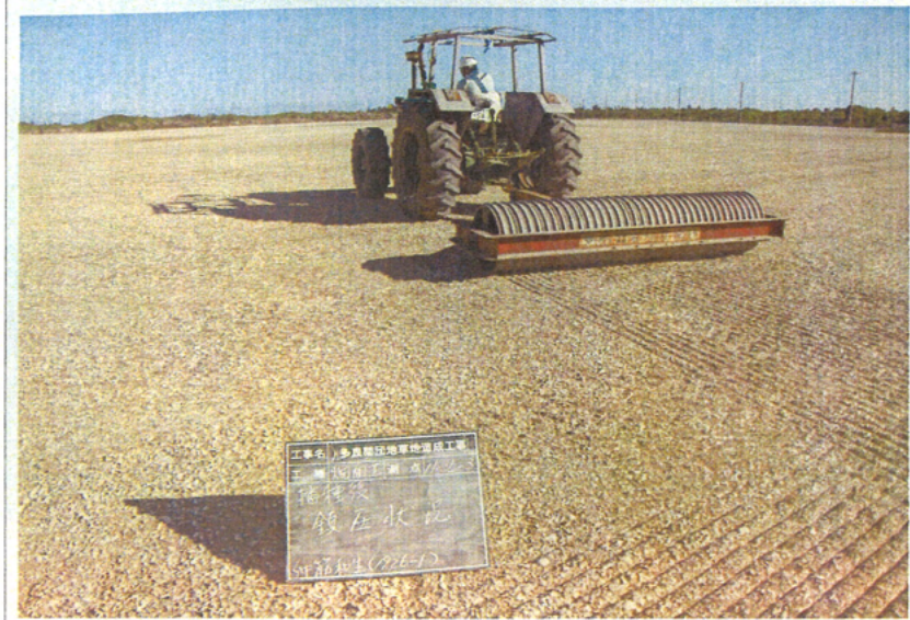
鎮圧(ケンブリッジローラー)
