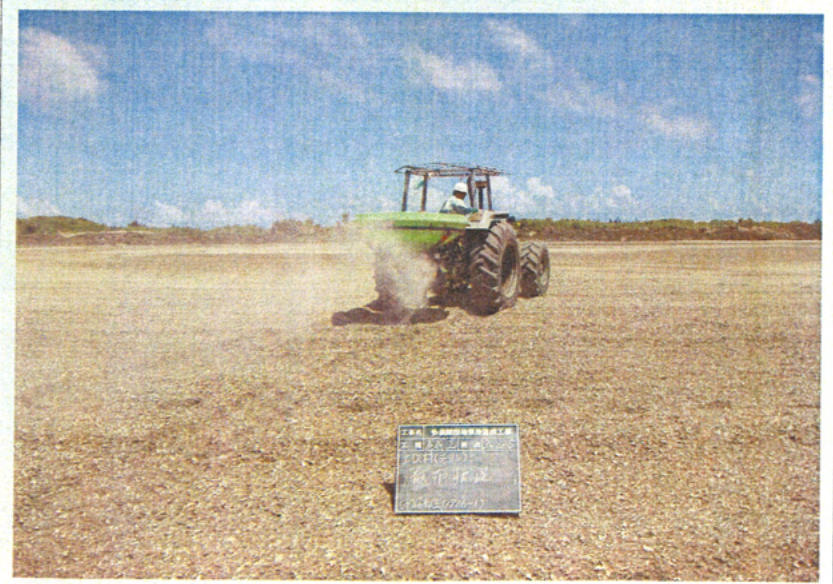
土壤改良材散布 (BMヨーリン)
